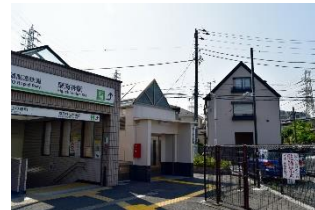
住宅街の中にある「東海神」駅の出入口。改札・ホームは地下階
