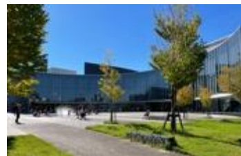
区役所や図書館、ホールなどを複合化した「プラザノース」
