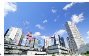
「西新宿」西側、「西新宿五丁目」北地区の開発中の様子。大規模タワーマンションが複数棟建設中
